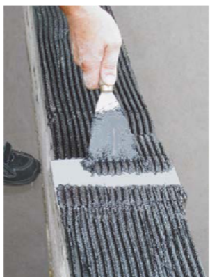
Nałożenie Enkolit na blachę kompensacyjną
