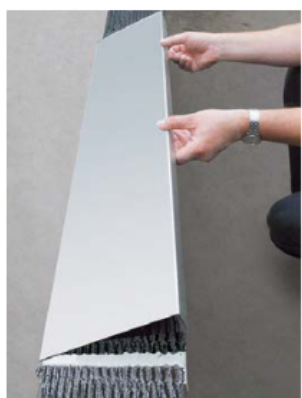
Umieszczenie obróbki blacharskiej
