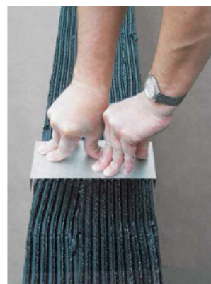
Wklejenie blachy kompensacyjnej
