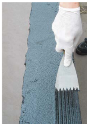
Rozprowadzenie Enkolit szpachlą zębatą
