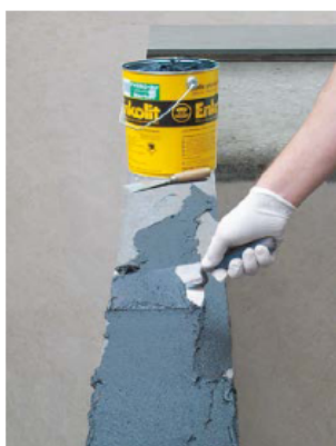
Nakładanie Enkolit kielnią lub pacą
